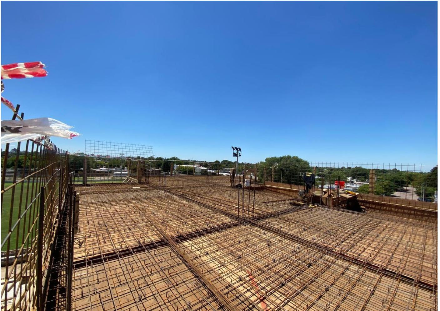
Armado losa con armaduras - 30m3. LOSA SECTOR C – 2DO PISO
