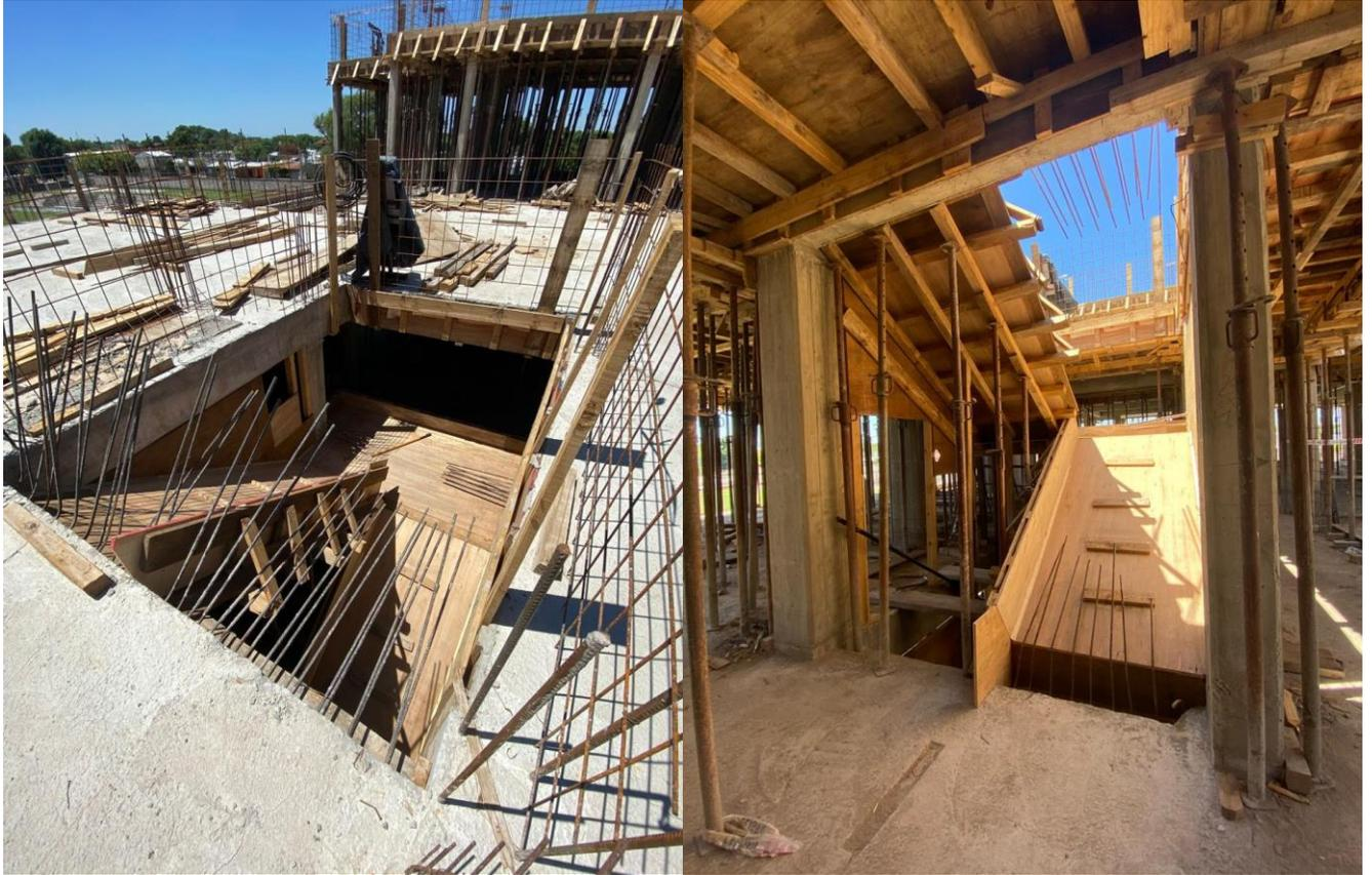
*Construcción de encofrado escalera de primer piso*
